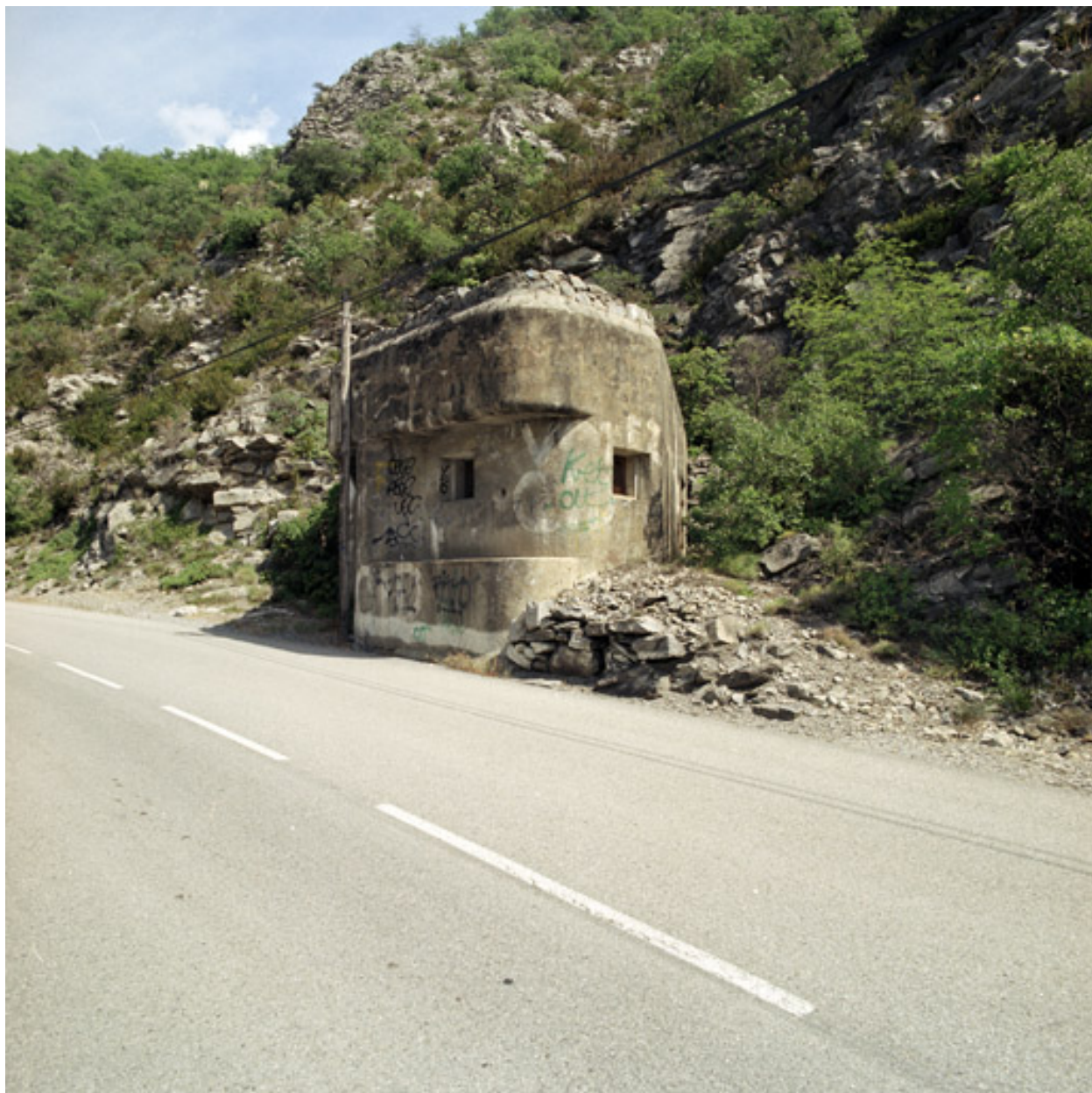
Flanc et gorge de la casemate, avec deux créneaux pour fusils mitrailleurs (F.M.).
