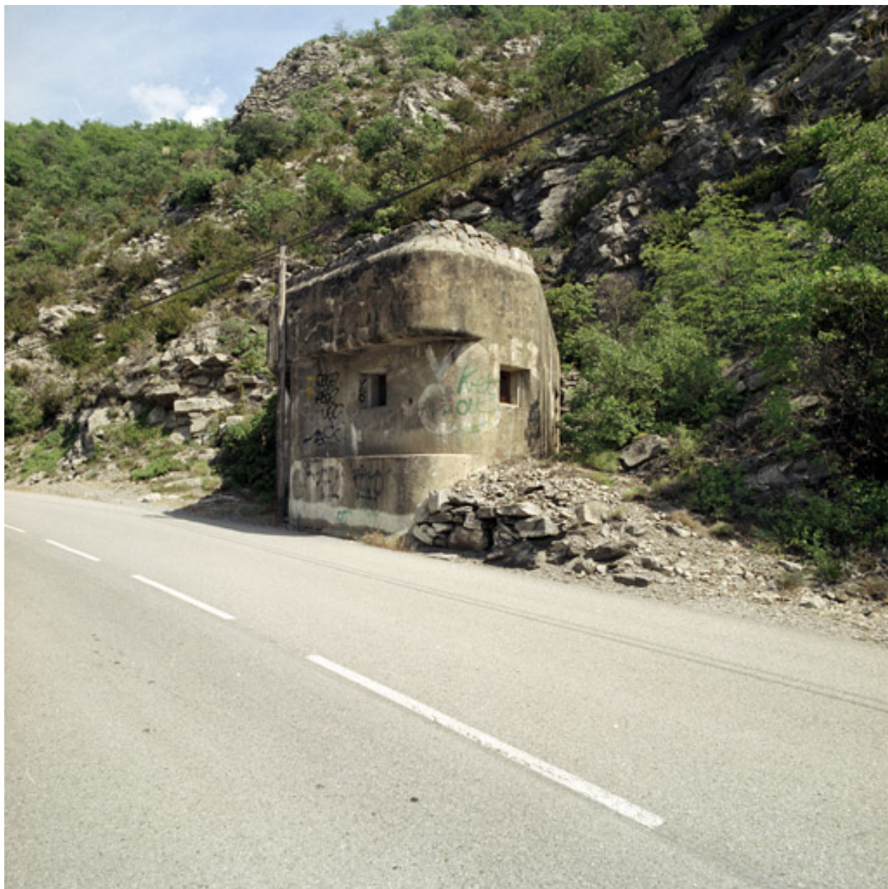
Flanc et gorge de la casemate, avec deux créneaux pour fusils mitrailleurs (F.M.).
