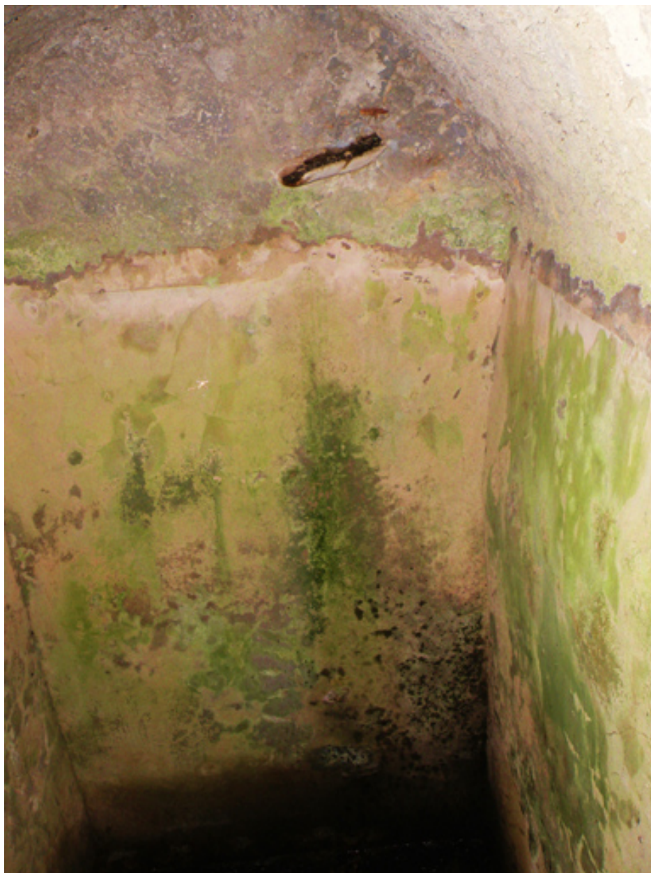
Saint-Pierre Le Château, parcelle 1980 A2 583. Vue de volume d'une citerne.
