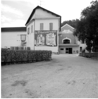
Volume partiel et élévation vus du sud. Phot. Marc Heller IVR93_19898300586X
