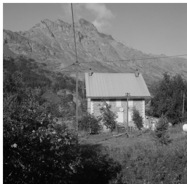
Façade est, prise de la route. Noter le lambrequin, les faux-chaînages et les encadrements des fenêtres. Phot. Gérard Roucaute IVR93_19810500243X
