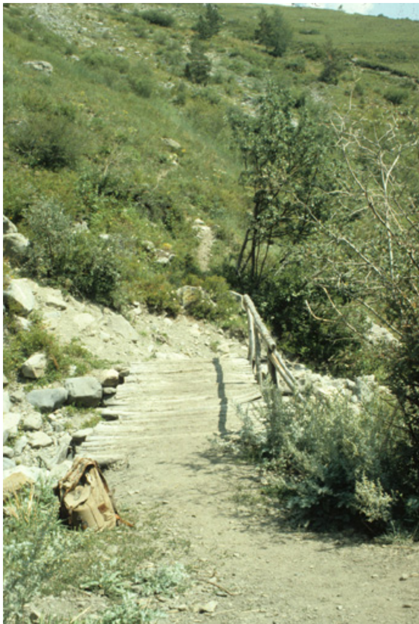
Torrent de la Moulette. Pont en bois sur la route des alpages.
