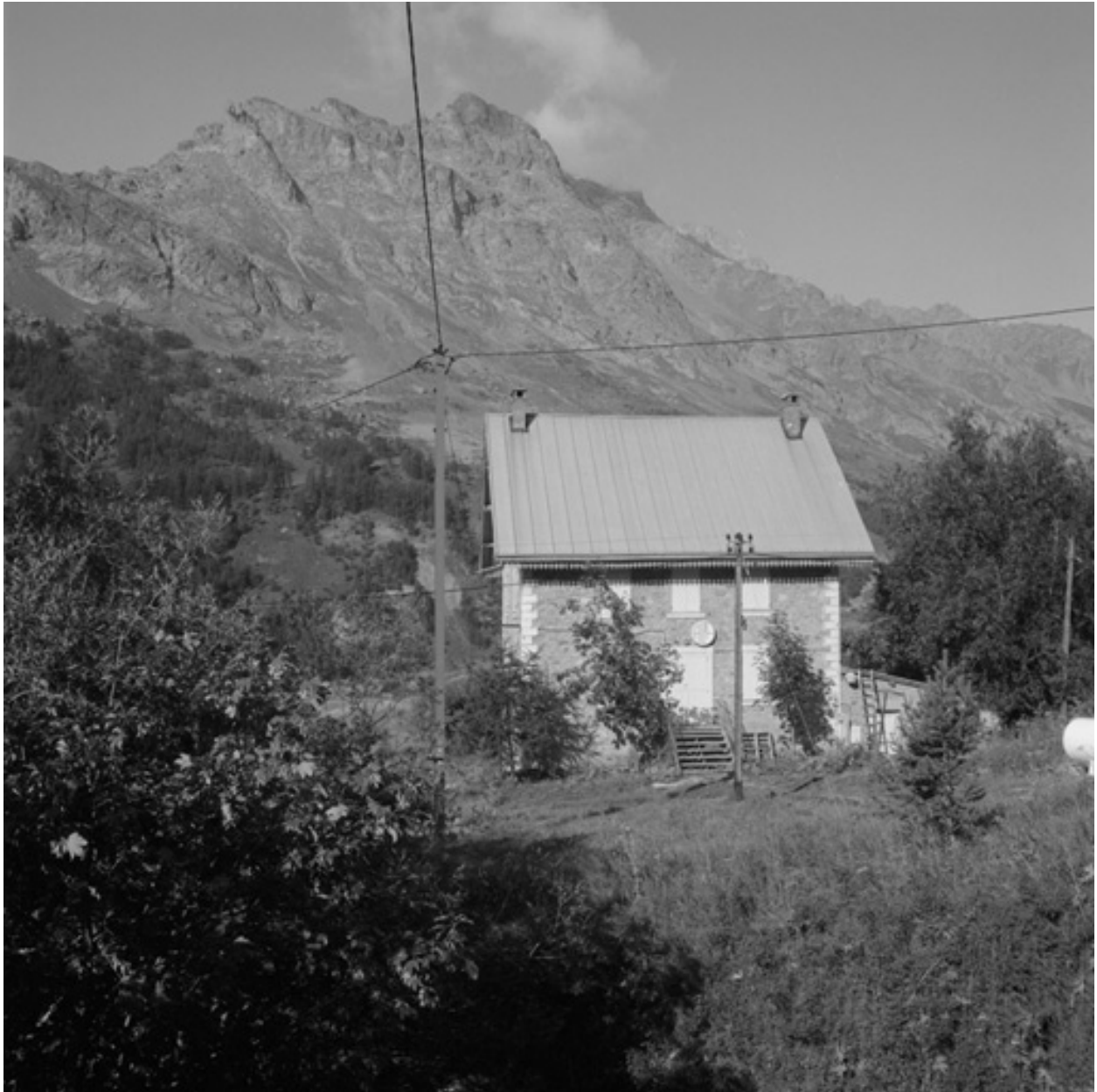
Façade est, prise de la route. Noter le lambrequin, les faux-chainages et les encadrements des fenêtres.
