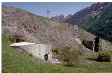
Vue d'ensemble extérieure. Au premier plan, le bloc 1 et sa cloche, au second, le bloc 2. En fond, versant nord-est de la Crête de la Duyère, de l'autre côté de l'Ubayette.
