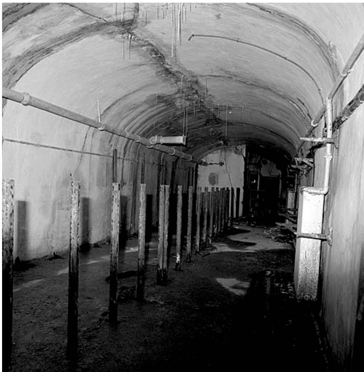
Galerie principale. A gauche, restes des supports des lits de la troupe et gaine de ventilation (local 14). A droite, le long du mur, vestiges des planches à paquetage et du chauffage central.
