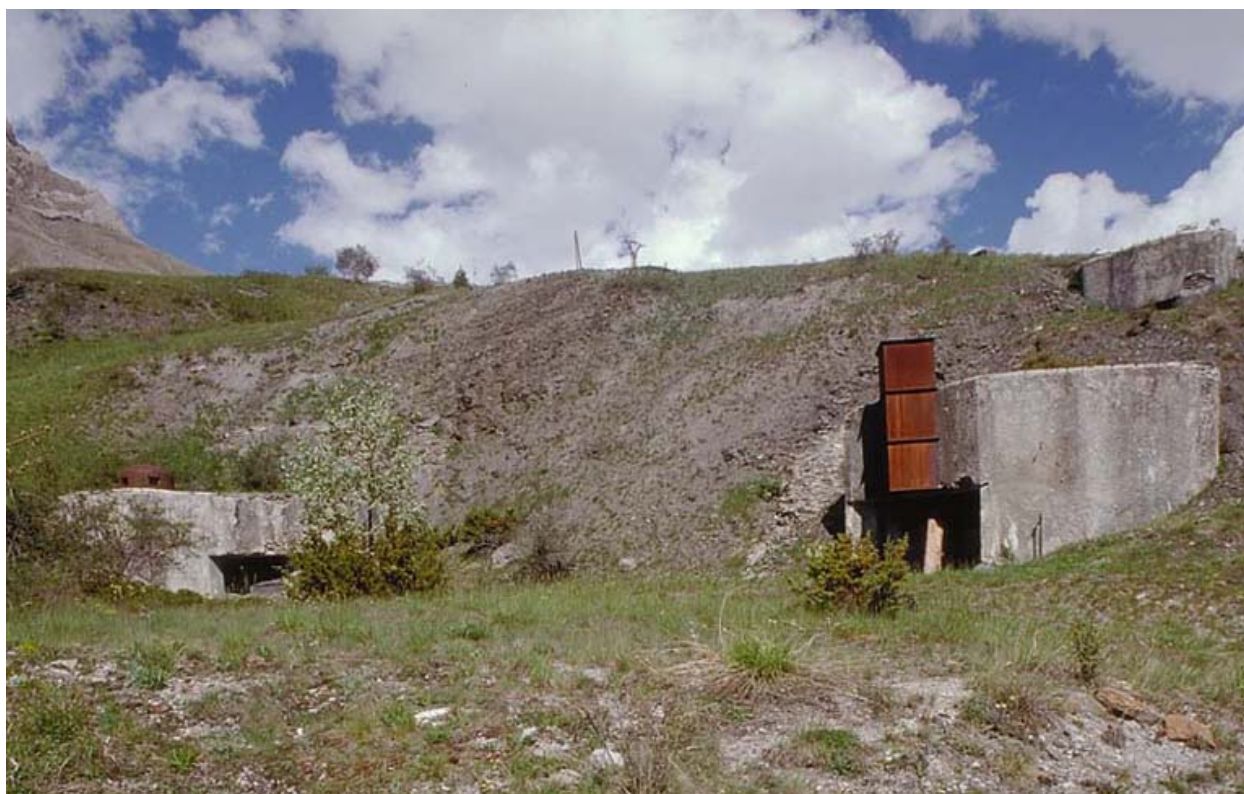
Vue arrière. A gauche, B1. A droite B, avec la cheminée d'accès par temps de neige.
