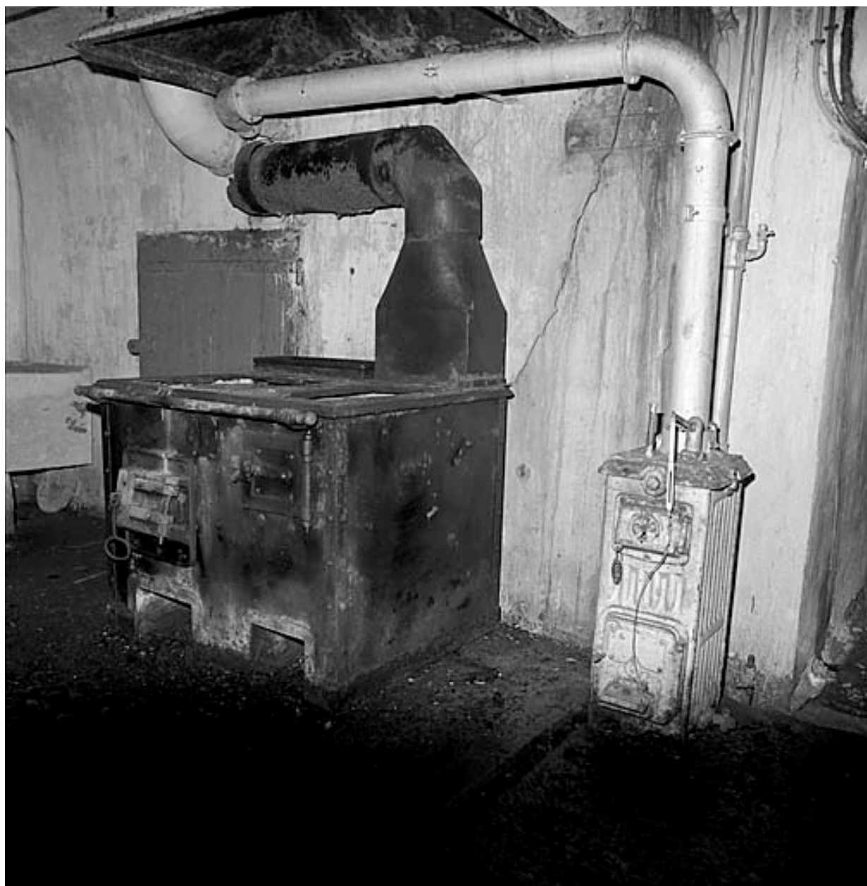
Cuisine et chaudière de chauffage central.
